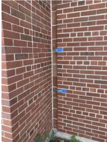
2026.07.02 – CJ caulk mock-up
