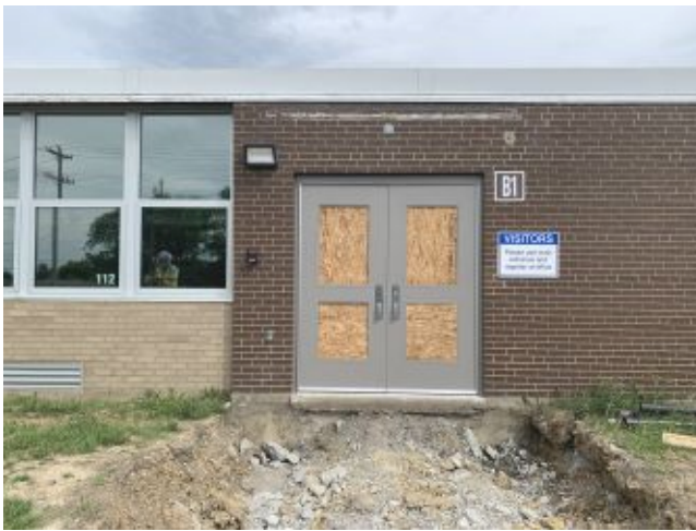
2026.06.11 – Sidewalk demo at bus door
