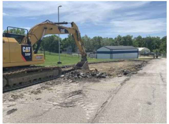
2026.06.04 – Asphalt removal
