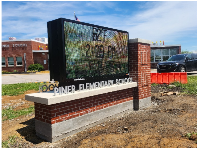
2026.05.06 – New marquee sign.
