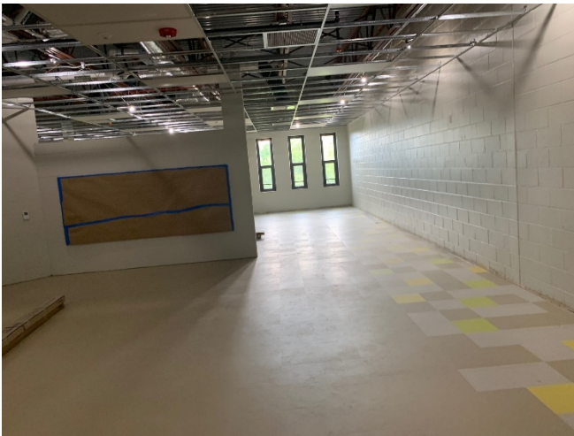
2026.05.05 – Phase 3 kindergarten classroom pod
