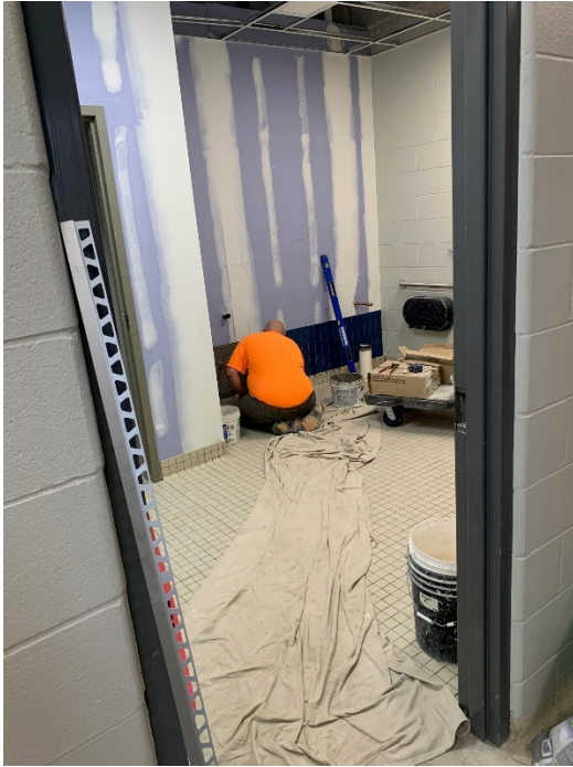
2026.05.05 – Phase 3 ADA restroom
