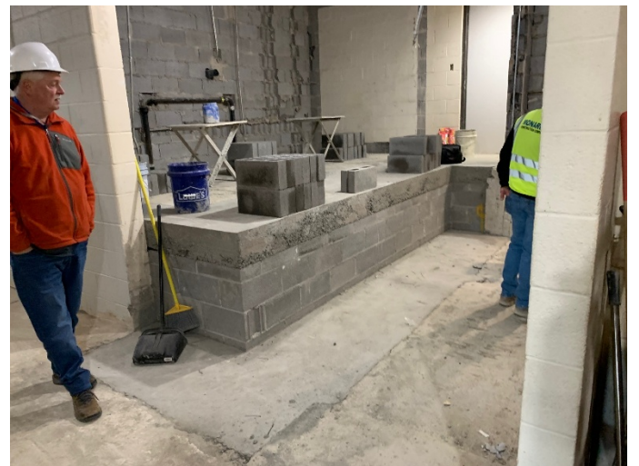
2026.04.07 – Phase 3 boys bathroom
