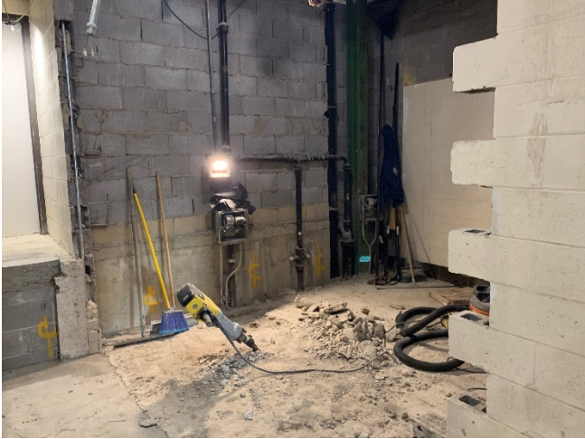
2026.04.07 – Phase 3 boys bathroom
