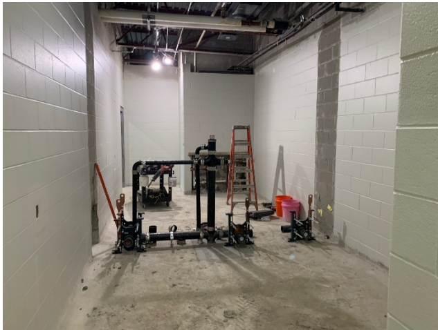
2026.04.07 – Phase 3 Kindergarten bathrooms
