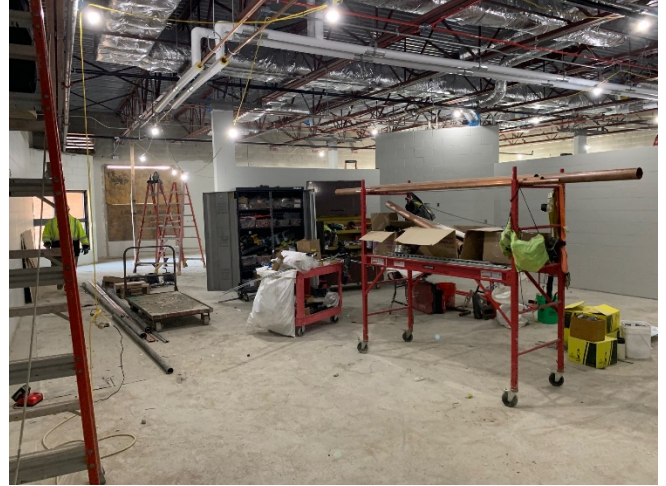
2026.04.07 – Phase 3 Kindergarten pod
