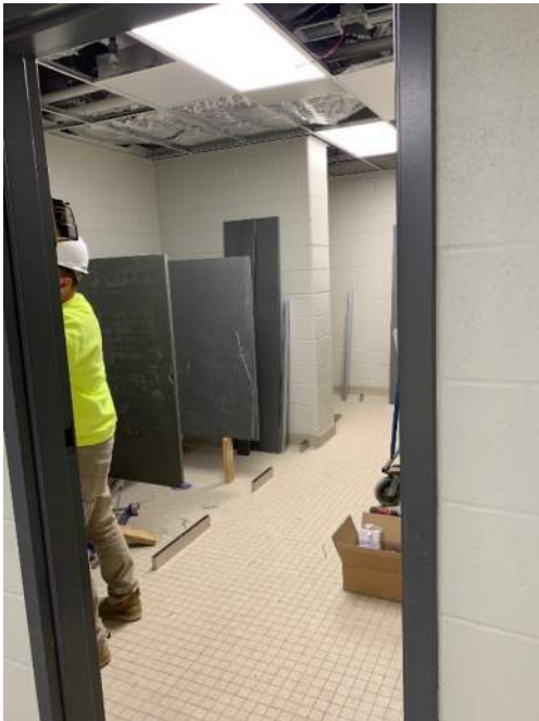
2026.02.24 – Phase 2 Girls restroom
