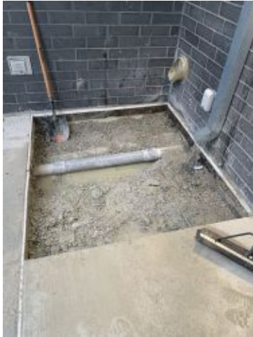
2025.11.18 – The repaired communications conduit
