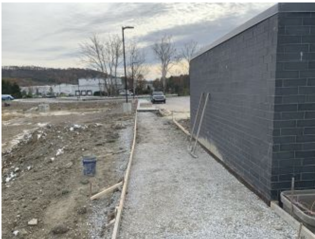
2025.11.11 – Remaining sidewalk pour
