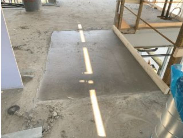
2025.04.01 – Slab pour north of operable partition pocket
