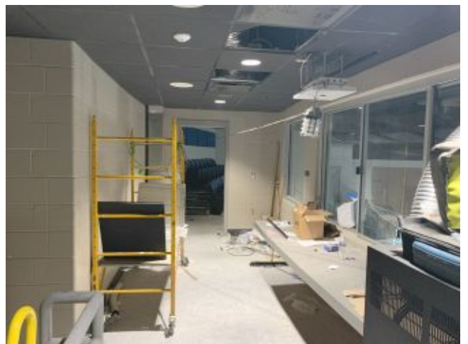
2024.05.15 – Control Booth #2040A
