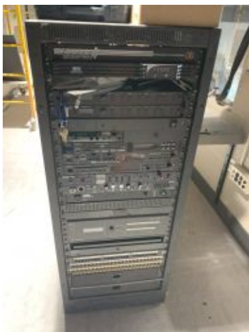
2024.05.15 – Control Booth #2040A
