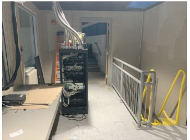
2024.05.15 – Control Booth #2040A
