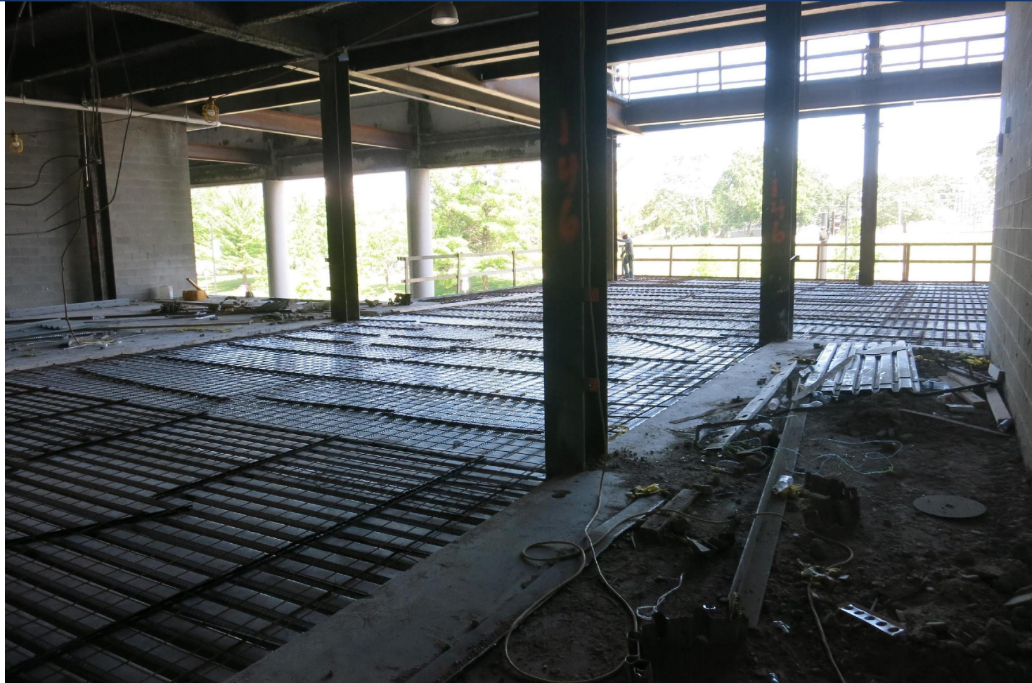
Level 2 Deck Prepped for Slab Pour
