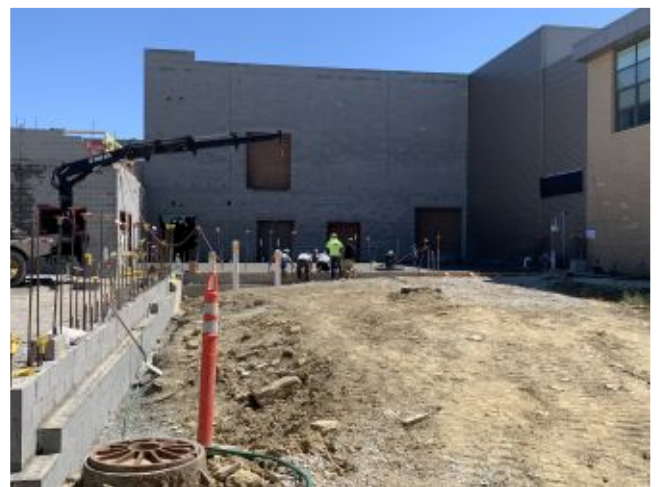
2022.06.30 – Scott monumental stair lobby
