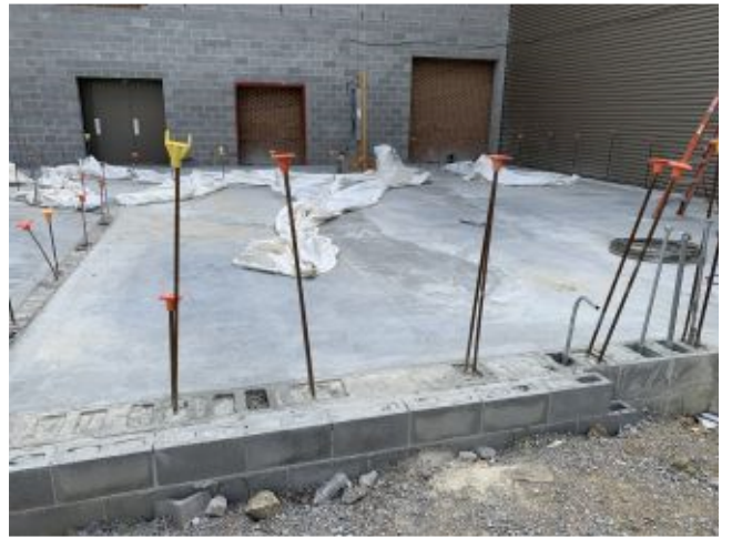
2022.07.13 – Monumental stair lobby
