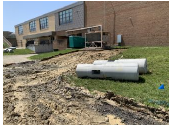
2022.06.15 – Precast light pole bases
