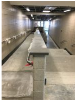
2017.04.12 – Ramp wall cap
