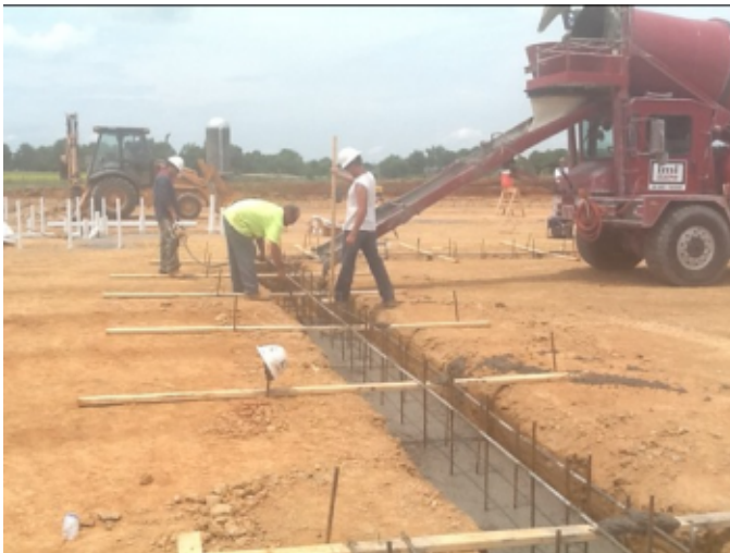
Photo # 28 - Concrete Pour
