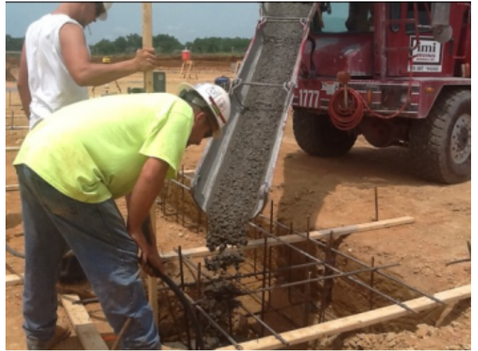
Photo # 27 - Concrete Pour
